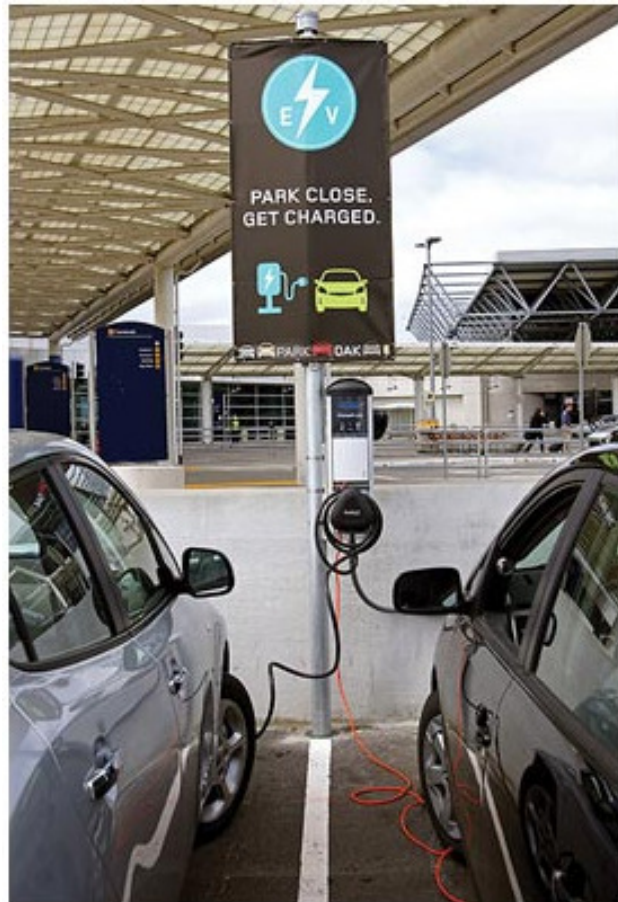
Figura 5 – Estação de carregamento nível 2
